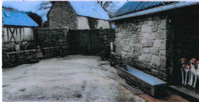
Chenil HAUT : chenil secondaire, chiots et femelles en chaleur, infirmerie Maçonnerie de pierre et de parpaing de 10 Travaux prévus, enduits et isolation plafond en panneaux sandwich de 10cm
